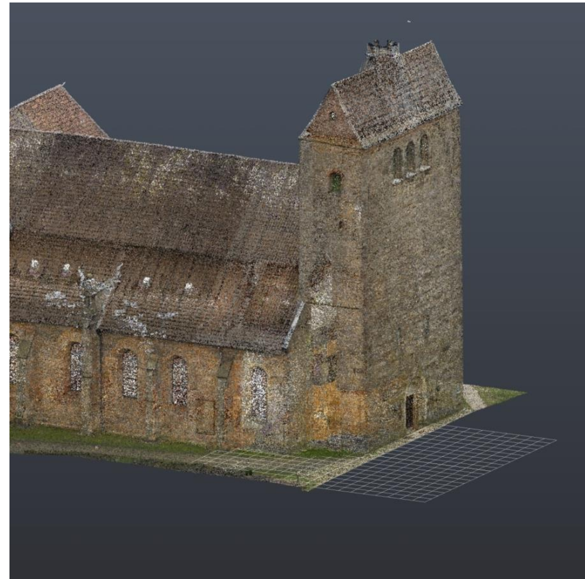
Externe Dienstleister: Erfassen des Gebäudes als 3D-Punktwolke
